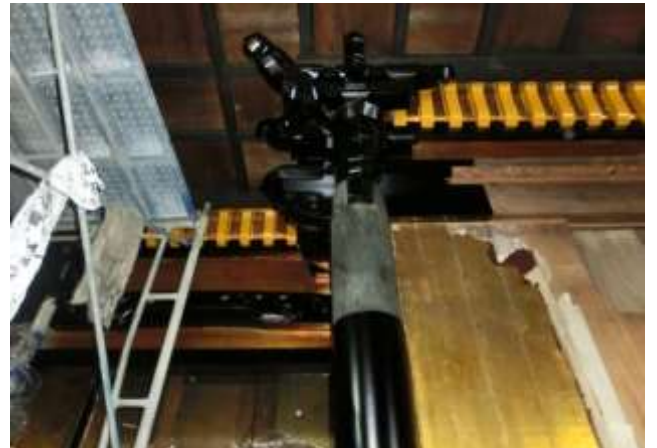
幾重にも塗り重ねられて、漆の黒いツヤが増してきました。玄関に入ると、ツーンと酸っぱい漆の匂いが漂います。白の下地には黄色い下地が重ねられました。
