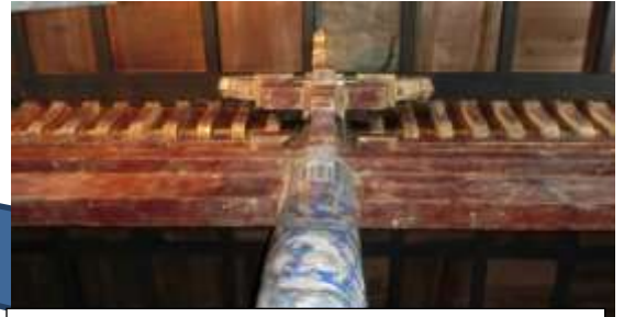
前頁①の工程です。まずは削る作業が続きました
