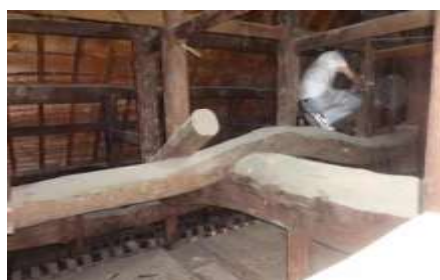
本堂の天井裏の配線をすべ て交換していただきました
