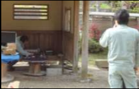
屋外音響システム設置
