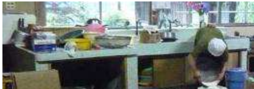
タイル張りで低かった以前の流し台 調理台や収納スペースがきゅうくつでした
