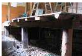
意外に床下は痛んでいませんでした
