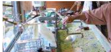
大きな鍋を使うには少し浅かった以前の流し台 タイルもはがれていました
