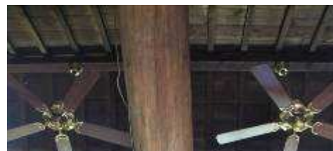
天井を張るのは大がかりで費用もかかるので 清掃してファンを設置しました
